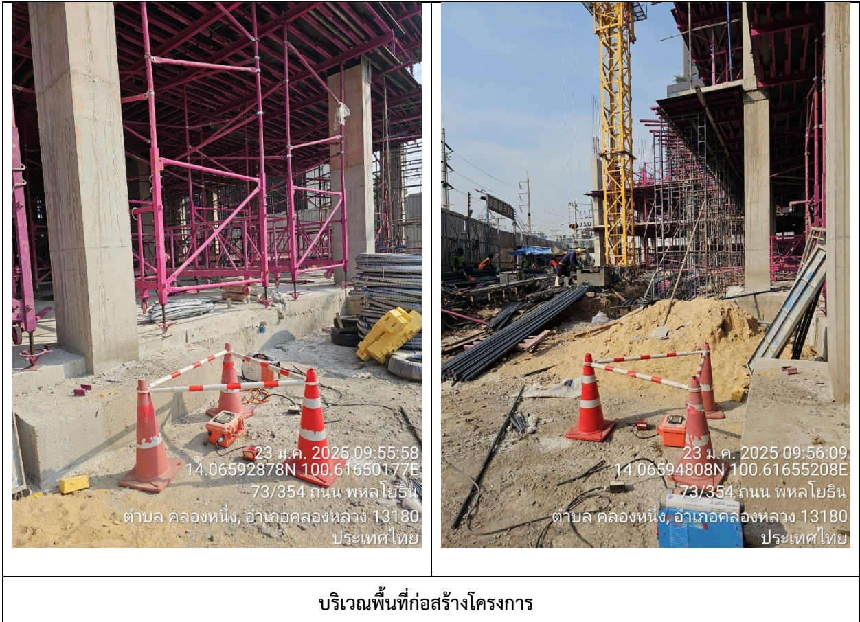
รูปที่ 3.3-2 การติดตั้งเครื่องตรวจวัดความสั่นสะเทือน
